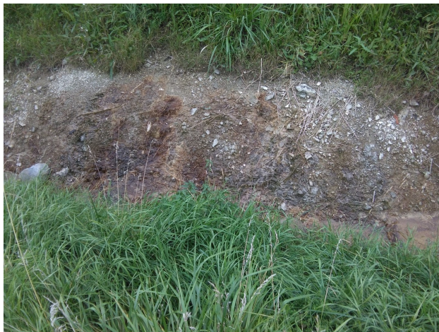
Joonis 5. Nõrgvee prügilast välja filtreerumine Uus-Sadama tee ääres asuvasse prügila ringkraavi
