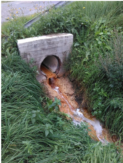
Joonis 4. Võimalik kipsi väljasadestumine
