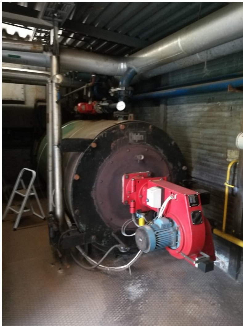
Joonis 3 – Aseri kaugküttepiirkond, 1,23 MW Högfors gaasikatel
