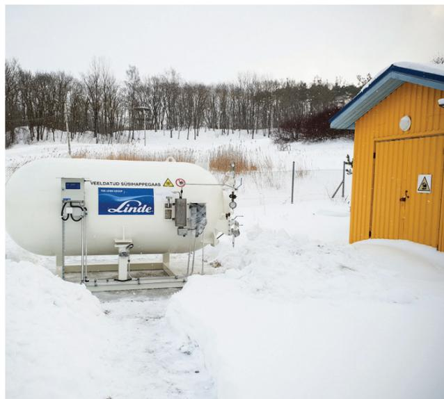
Закрытая свалка в Кунда получила новую систему очистки сточных вод. Новая очистительная станция по очистке сточных вод, которая работает на CO<sub>2</sub>, более надежнее, дружелюбнее к окружающей среде и мощнее, чем предыдущая, работающая на серной кислоте.
