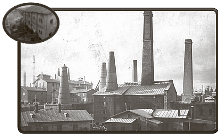
Vabrikus kasutati esmakordselt Eestis elektrienergiat elektrimootorite käivitamiseks
