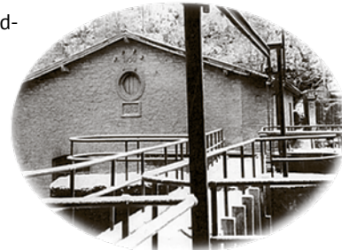
Vaade hüdroelektrijaamal hoonetele paisu poolt 1959. aastal
