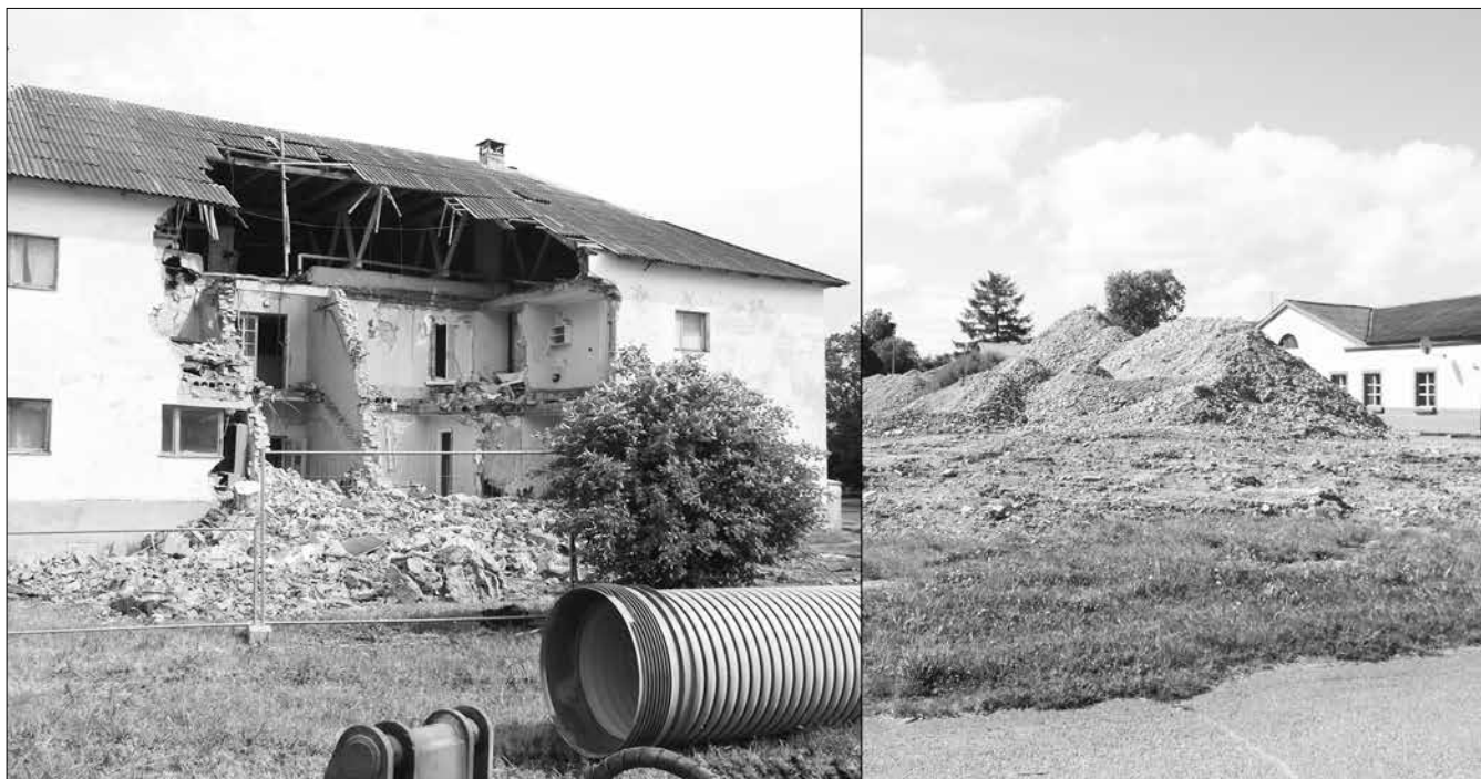
Для того, чтобы строить новое, надо сносить старое и ненужное!
