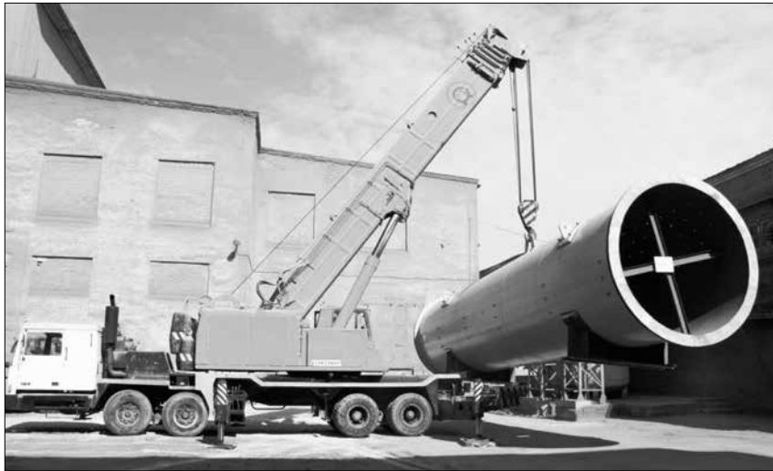
Tooraineveski korpuse sisediameeter on 3 meetrit, pikkus 14 meetrit ning mass 49 000 kilogrammi. Foto KNC arhiivist
