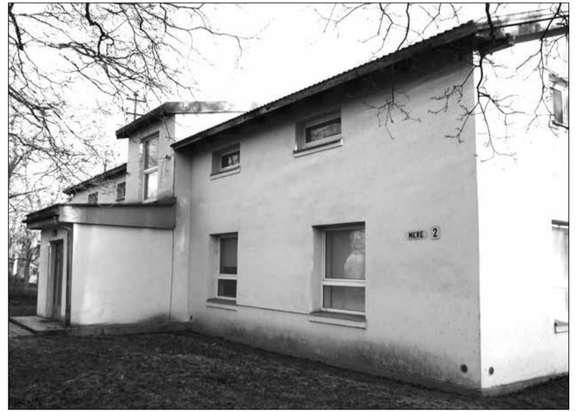
Бывшее здание музыкальной школы получит новое содержание и ухоженный внешний вид. Фото Hoolekandeteenused
